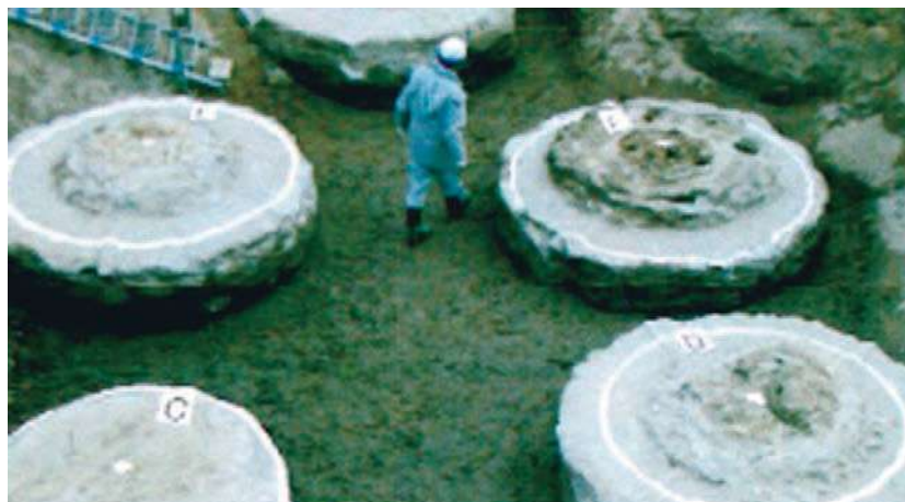
泥炭性软土地基中建造的桩式改良体 (使用SY201)
