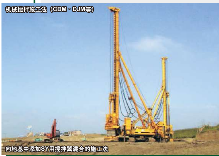
泥炭性软土地基中建造的桩式改良体 (使用SY201)
